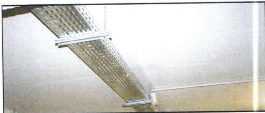
Kanalina metalike për magjistralet e linjave elektrike
