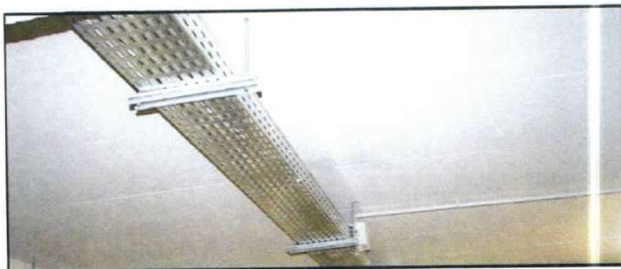
Kanalina metalike për magjistralet e linjave elektrike
